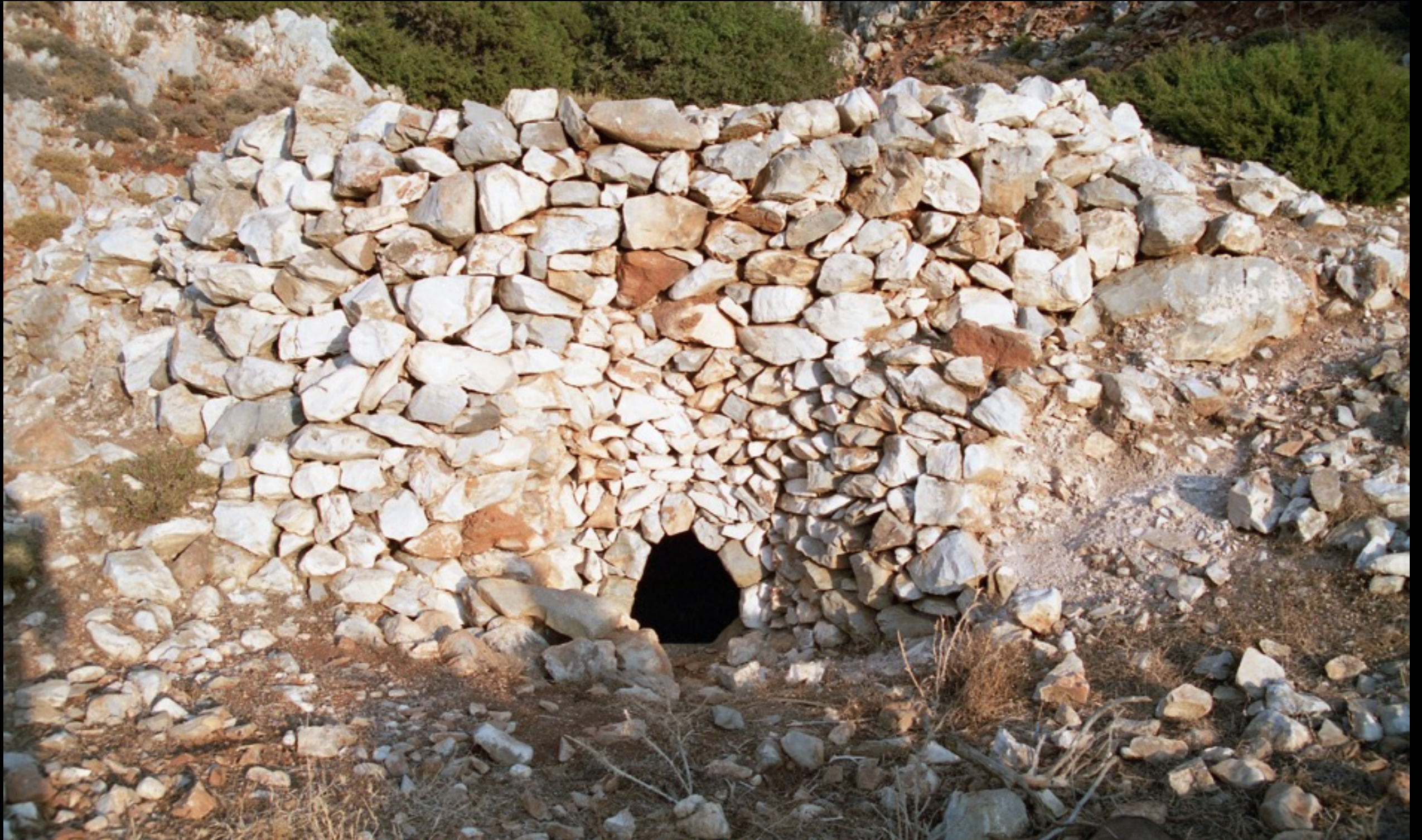
Structure en encorbellement, abri de berger ? île grecque de Kalimnos. (époque moderne)
